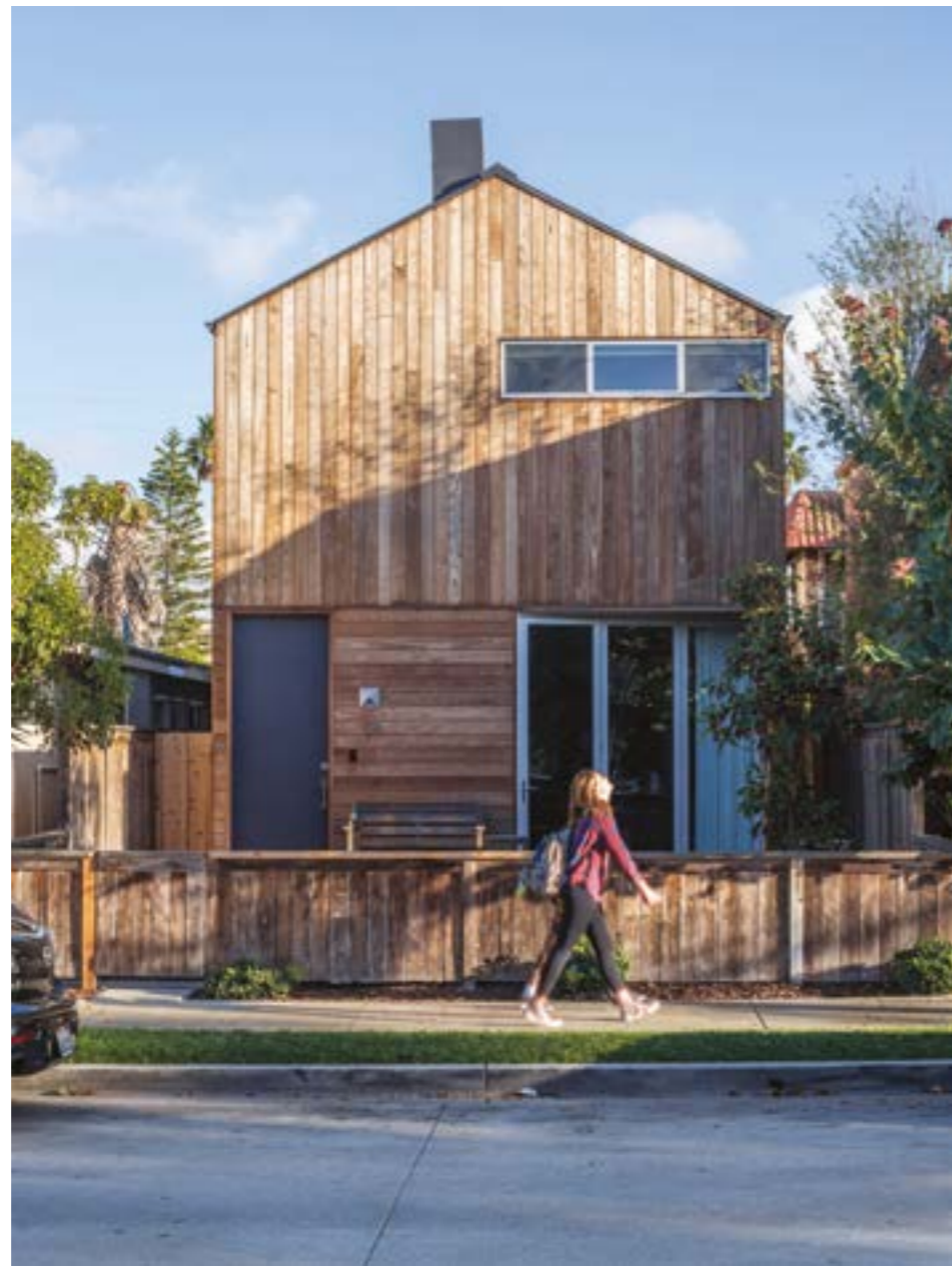
Benchmark Thermory თერმო-კოპიტის ფასადი ფარული ინსტალაცია PaCS-ით
